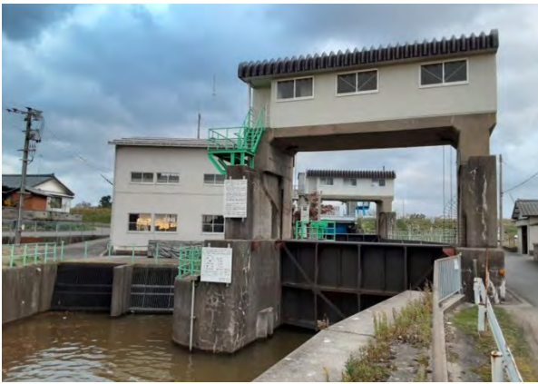
通船川の閘門（奥は阿賀野川）
