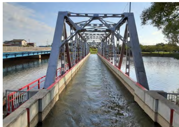
川の立体交差（上が西川、下が新川）
